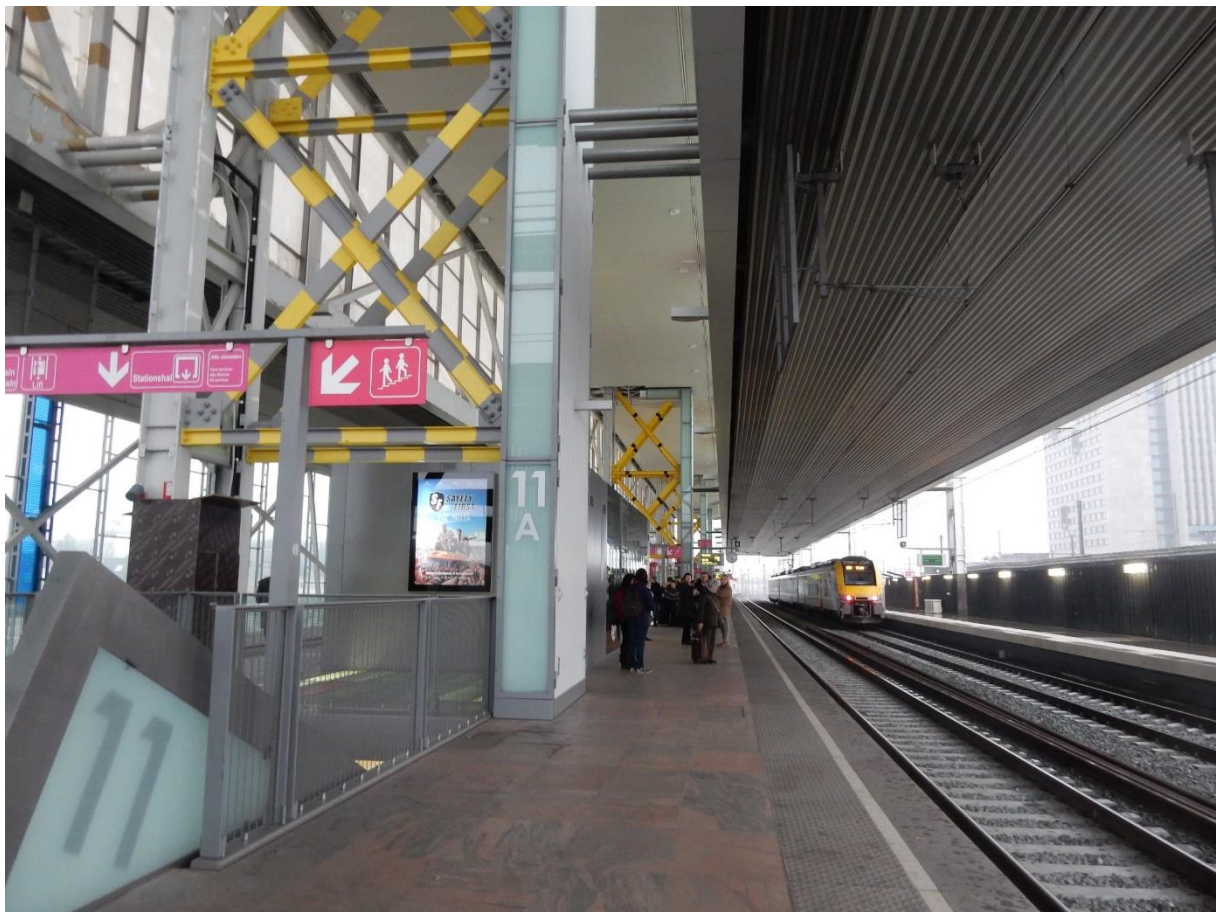
Het middelste deel van de perronoverkapping Foto: Marc Dubois
