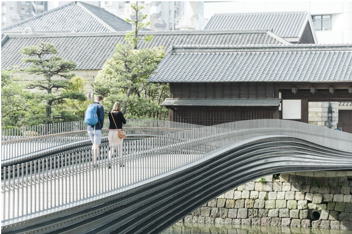
Nagasaki (Japan), de Dejima Footbridge (2016-2017) In 2021 kreeg Ney voor deze brug de First prize for urban design Award van de Japanse overheid. Foto Ney & Partners
